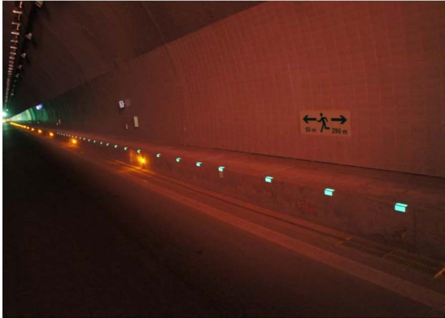
图20 隧道人行道、线缆槽转角自发光标识设置示例
